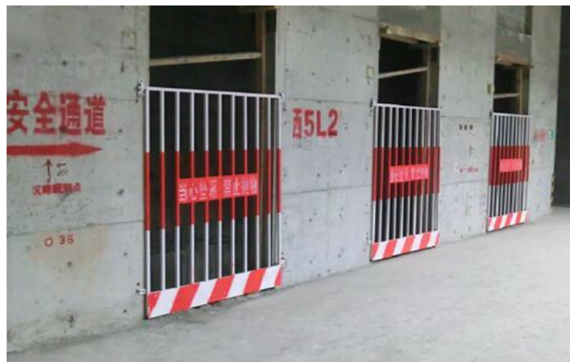
电梯井口防护实景图
