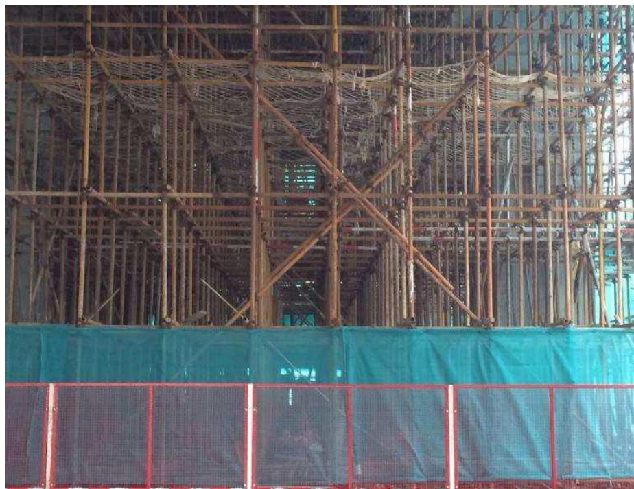
模板支撑架水平安全兜网实景图
