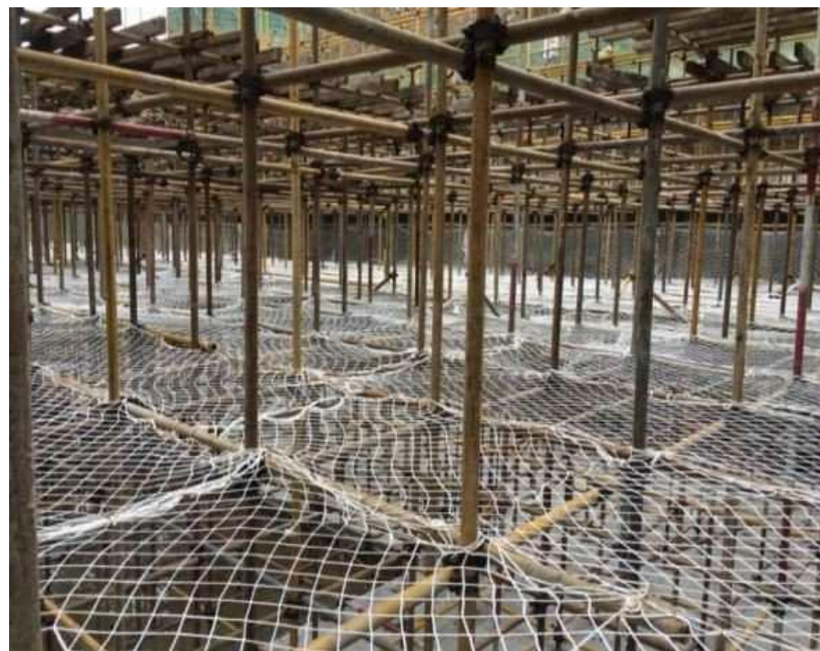
模板支撑架水平安全兜网实景图
