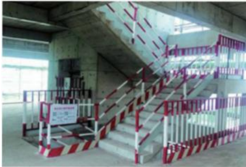
楼梯临边防护实景图1
