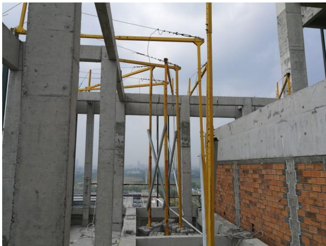
非标吊篮安装示意图
