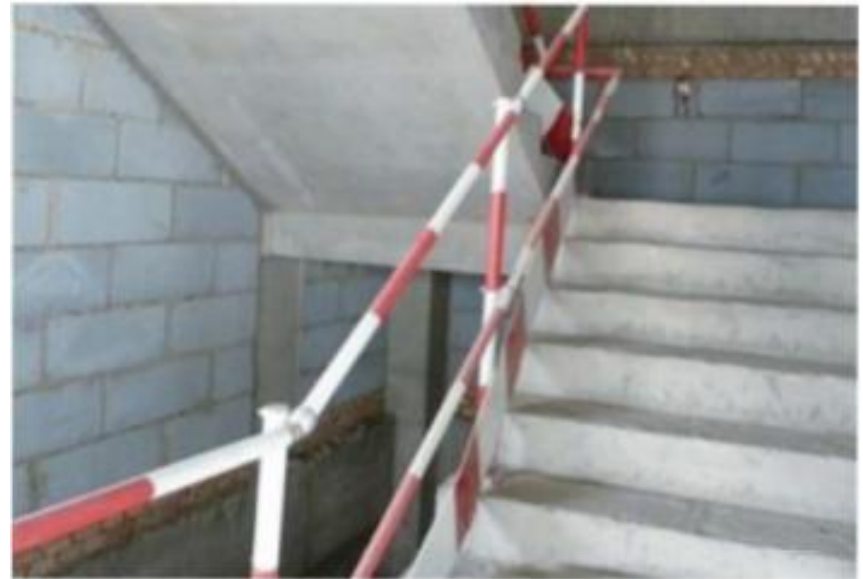
楼梯临边防护实景图2
